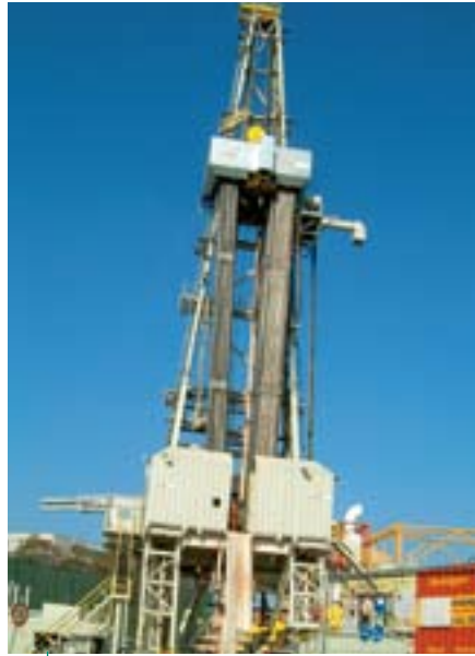
Tour de forage T45 du forage géothermique Bâle 1
